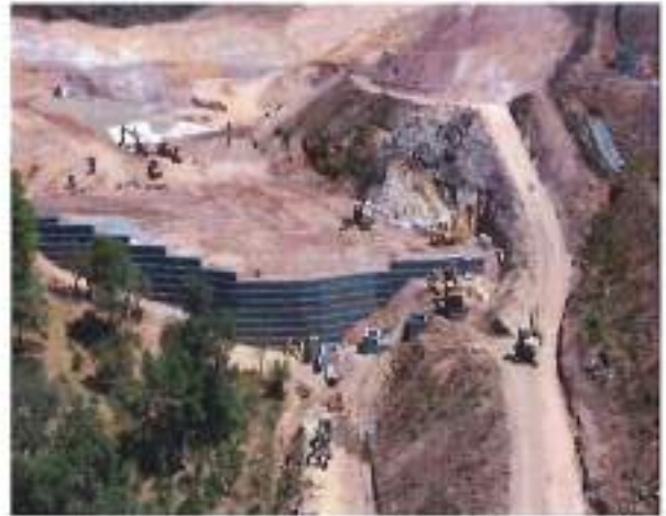
Figure 11 Mur en gabions soutenant les bassins pluviaux
