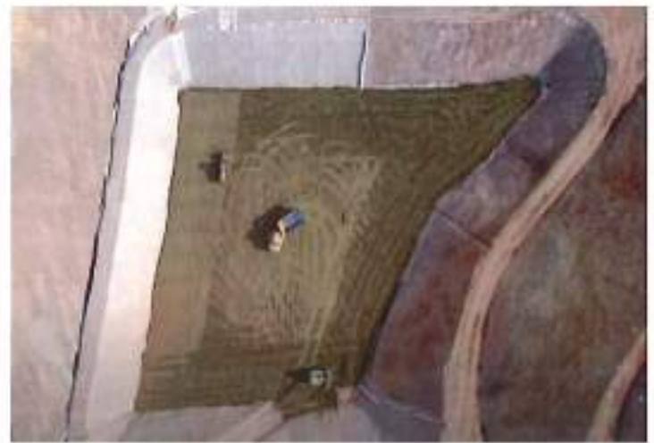
Figure 8 Mise en forme du casier
