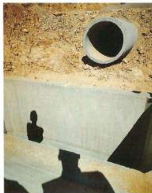
Figure 9 Caniveaux coulés en place
