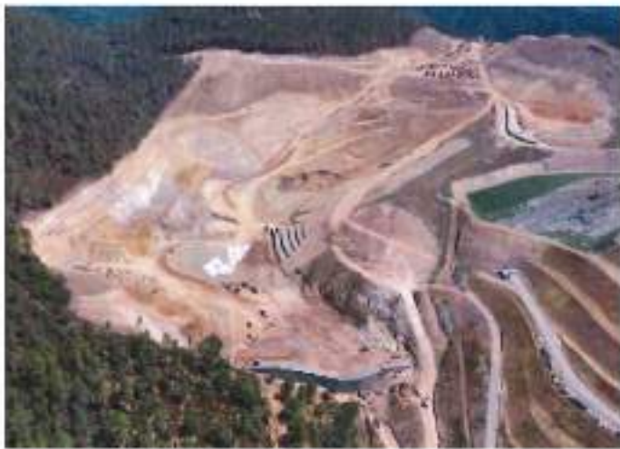
Figure 8 Mise en forme du casier
