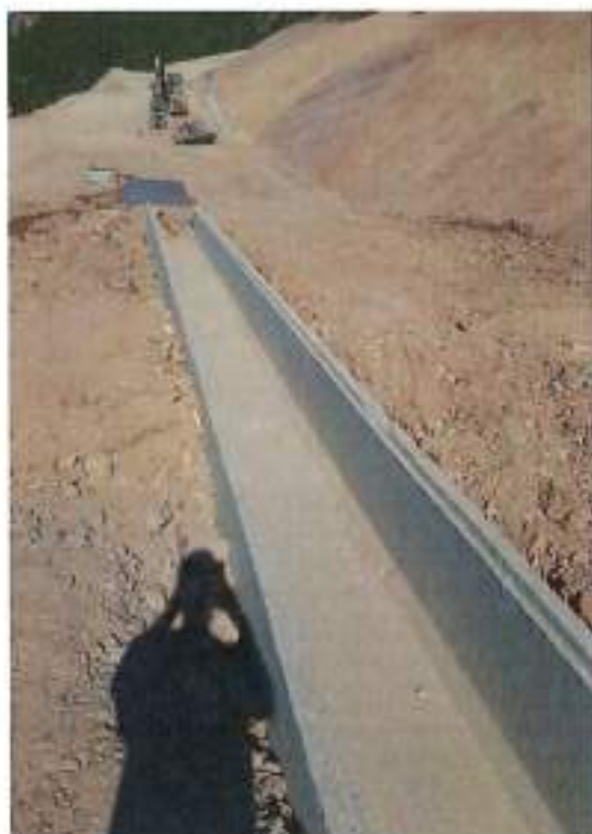
Figure 9 Caniveaux coulés en place
