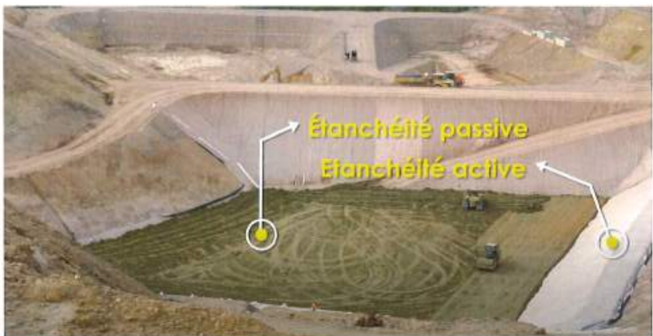
Figure 8 Mise en forme du casier
