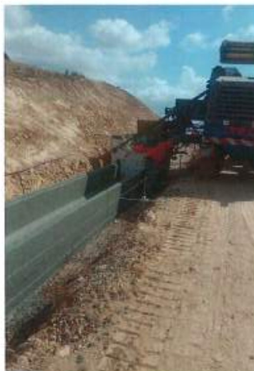
Figure 9 Caniveaux coulés en place
