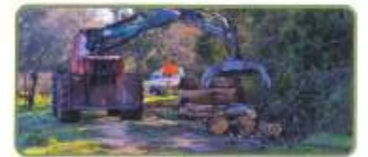
Sur l'Argens moyen, des travaux de désencombrement du lit ont été réalisés sur la commune Vidauban.
