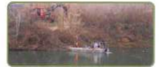
Sur l'Argens aval, les travaux d'entretien ont concerné l'Argens aval et l'Endre aval, sur les communes du Muy, Roquebrune-sur-Argens et Puget-sur-Argens.
