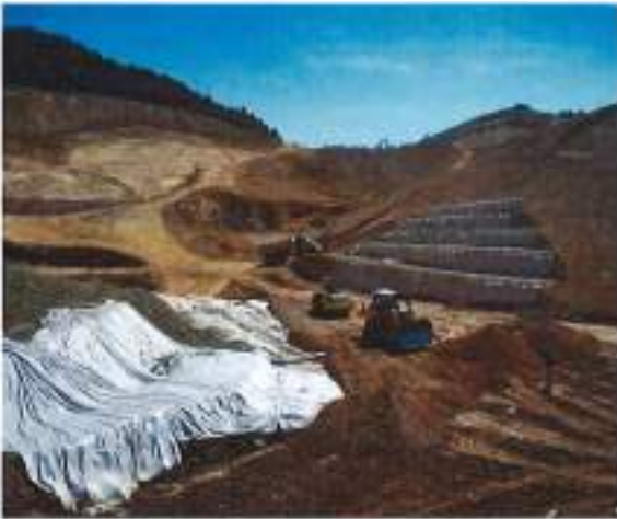
Figure 11 Mur en gabions soutenant les bassins pluviaux
