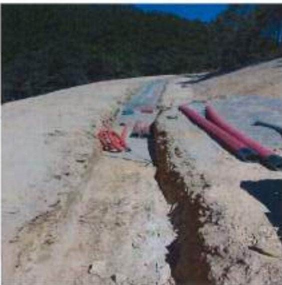
Figure 12 Réseaux secs et humides
