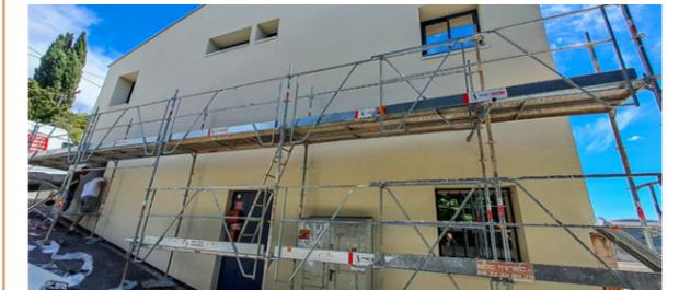
Le projet comprend l'ajout de 16 cm d'isolant sur la façade extérieure de l'école, ainsi que le remplacement de l'ensemble des fenêtres et portes extérieures.
